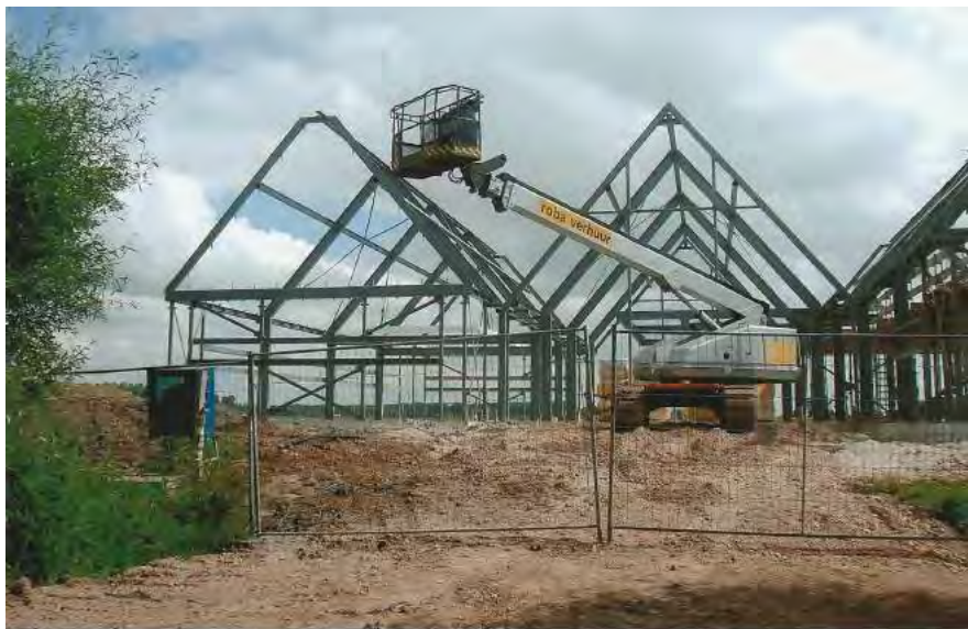
Eindprofiel al goed te zien!
